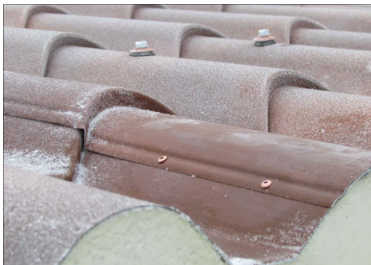
Esempio di corretto impiego di rivetti
